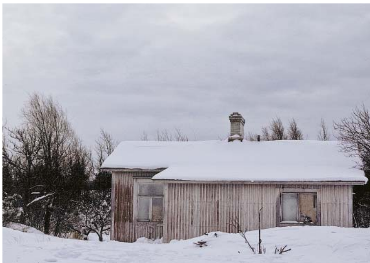
Tästä kaikki alkoi! Hangon lintuasemarakennus neitseellisessä tilassaan. © Jukka Haapala, 12.2.1979.
